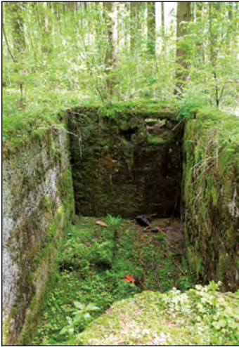
Überreste des Pumphauschens
