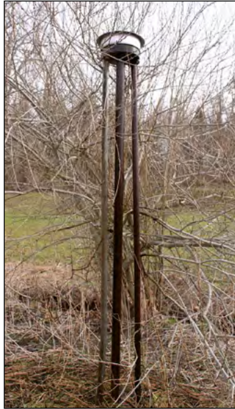
Gestänge und Verteilertopf – Schoidsaul
